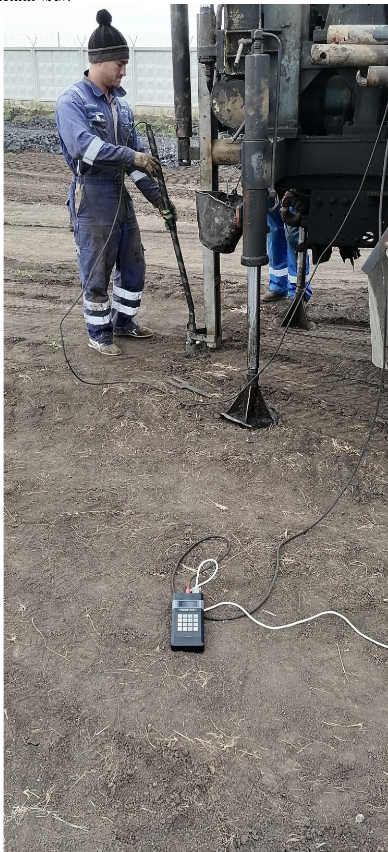
Рис.1.3 Статическое зондирование грунтов на площадке.
