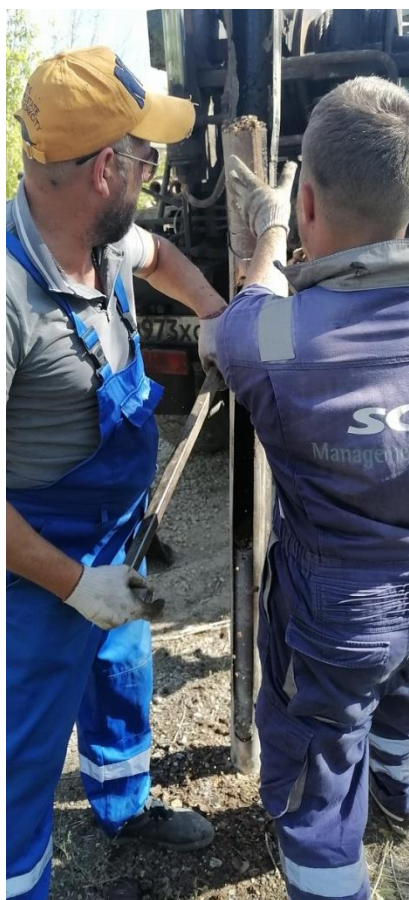
Рисунок 1.1 – Начало бурения установкой ПБУ-2 инженерно-геологической скважины
