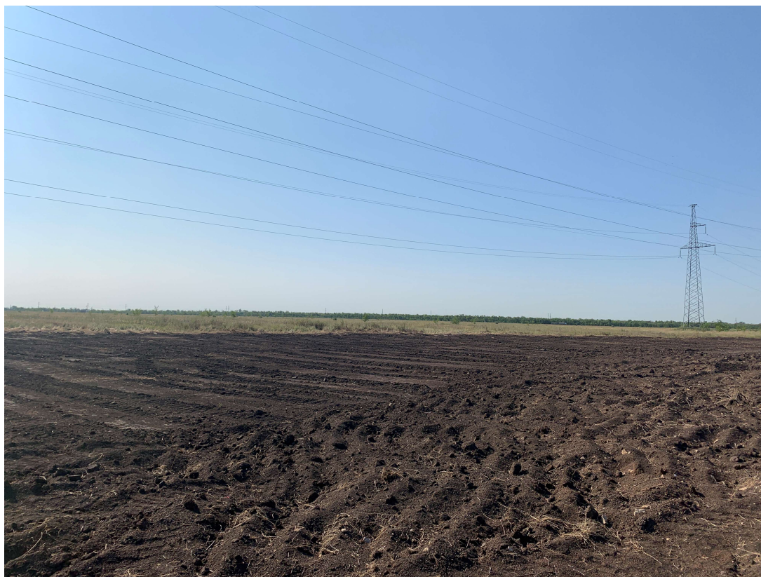
Рис.2. Т.Н. 1 Площадка строительства Т.Н.2
